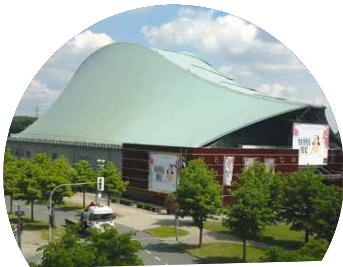
Neues Dach für das Stage Metronom Theater
